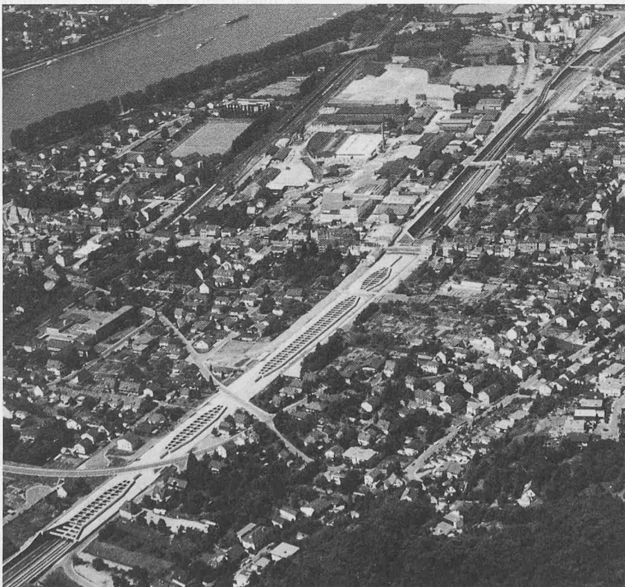
Bild 1. Lärmschutztunnel mit natürlicher Belichtung und Belüftung (Freigegeben Reg.-Präsident, Düsseldorf Nr. 56 946)
