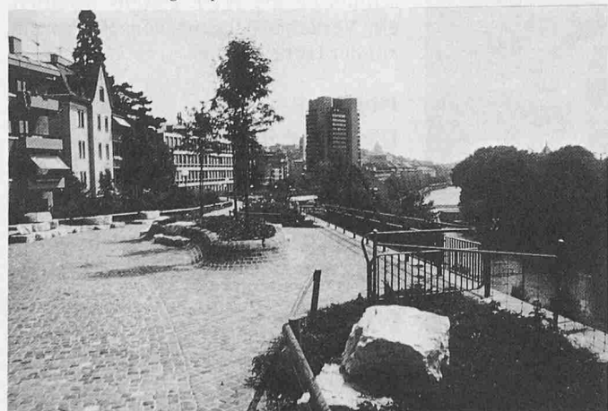
Bild 5. Überdeckung Südportal Milchbucktunnel. Rechts die Limmat
