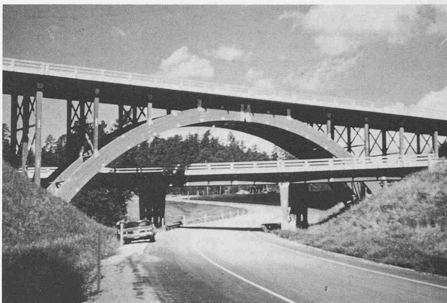
Selbst relativ grosse Brücken, wie diese Highway-Überführungen in Keystone, Wyoming/USA, lassen sich aus Brettschichtholzkonstruktionen erstellen, wenn ein wirksames Holzschutzkonzept angewandt wird
