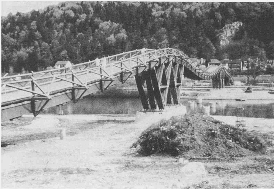
Bild 6. In einer flachen Wellenlinie, wie ein gespanntes, aber leicht durchhängendes Seil, führt die Fussgängerbrücke von Essing über den Main-Donau-Kanal
