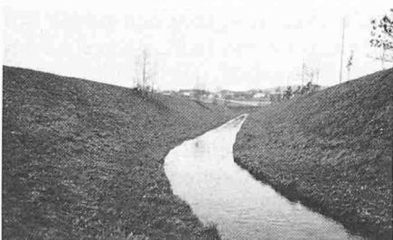
Bild 2. Revitalisierungsarbeiten am Nefbach, September 1986
