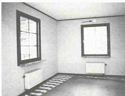
Bild 10. Regulierbare Zuluftöffnungen
