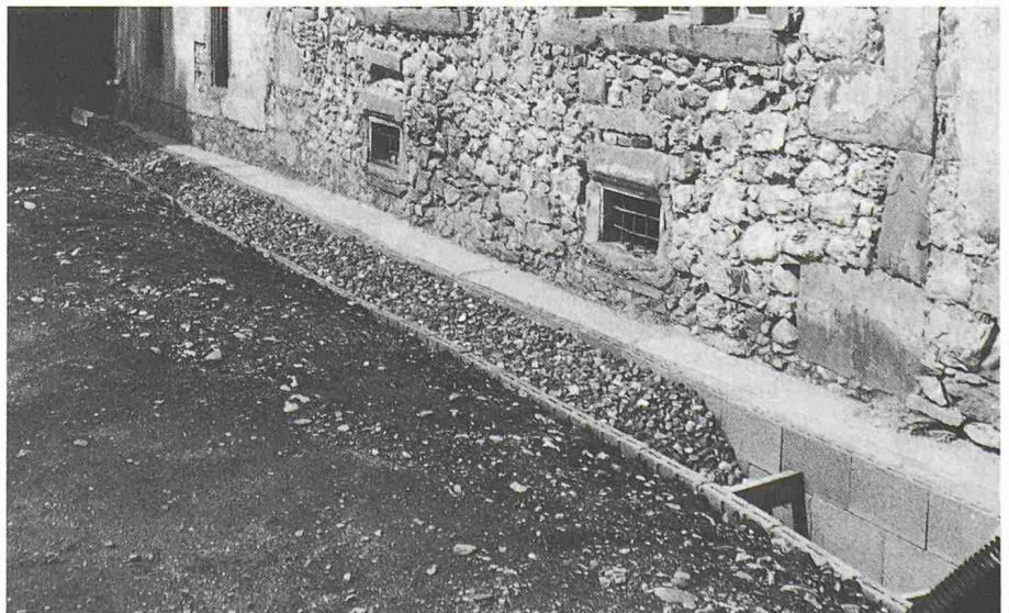
Bild 23. Dieselbe Mauer nach der Sicherung mit Fliessbeton (Bindemittel Hydraulischer Kalk HK). Sickerplatten, Sickerpackung und Drainage schützen vor Feuchtigkeit. (Winkelriedhaus Stans 1987)
