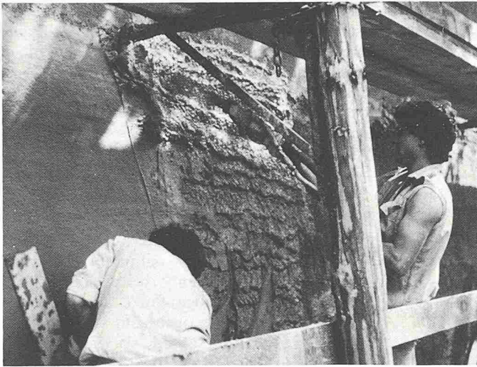
Bild 7. Renovation einer Fassade mit konventionellem HK-Grundputz mit Sand 0–4 mm. Dieser Mörtel wird gepumpt und mit der Spritzdüse aufgetragen. Durch das Verziehen mit der Latte entsteht eine Sinterhaut, die entfernt werden muss
