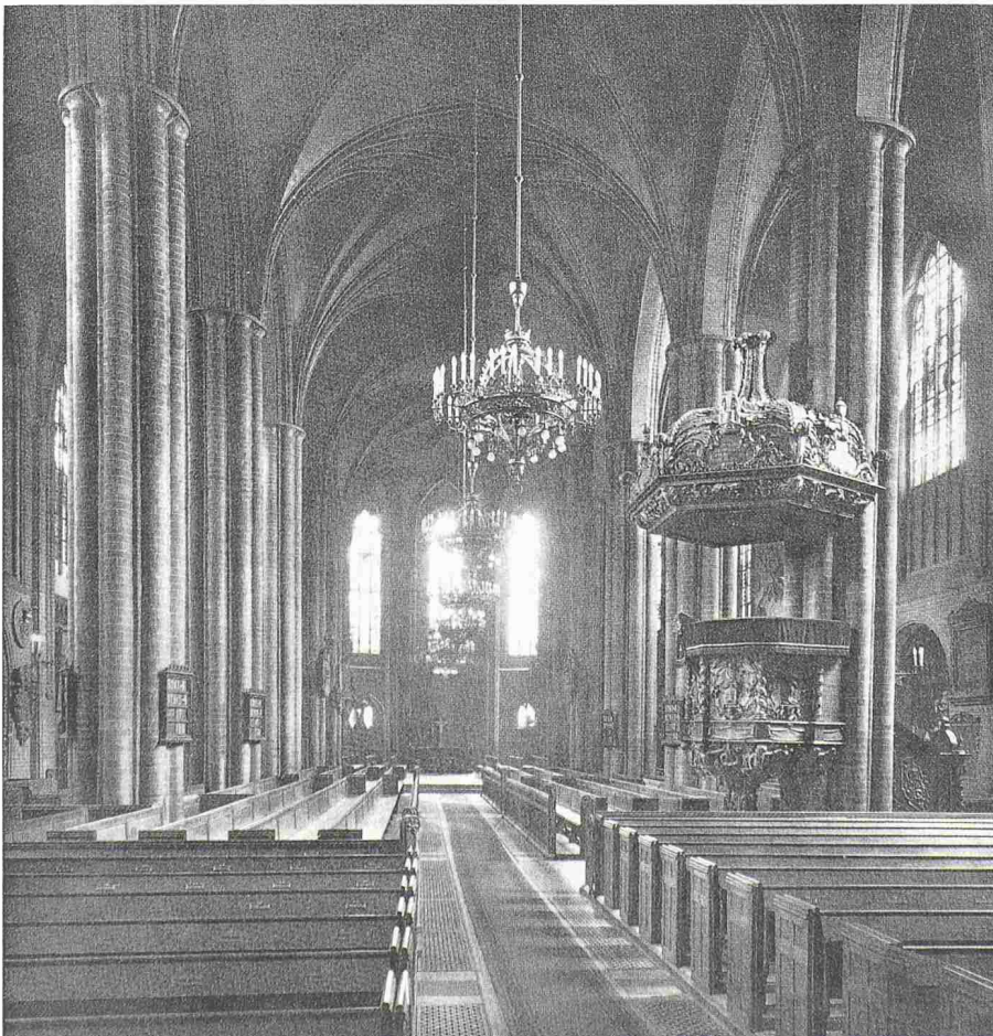
Die Nikolaikirche vor der Zerstörung, Hauptschiff
