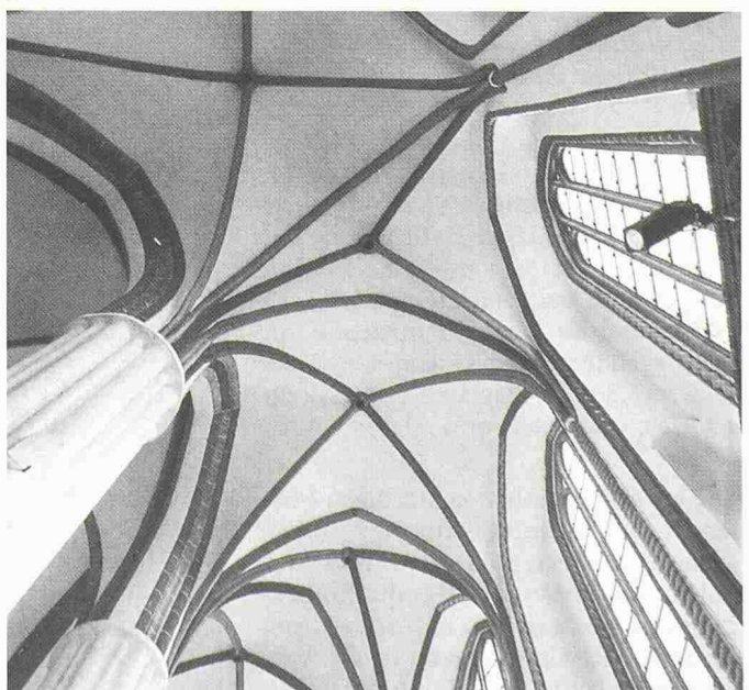
Chorgewölbe im Umgangschor mit dreistrahligen Kreuzrippengewölbefeldern, Farbwechsel im Bogenscheitel
