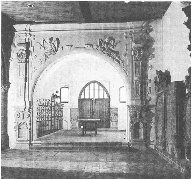
Bogenrahmung der Kapelle Kötteritz in Formen des späten Manierismus. Die Stuckverkleidung des Rippengewölbes durch Rollwerk aus der Entstehungszeit 1616 wurde unter Verzicht der figürlichen Darstellungen in den Kappenflächen erneuert
