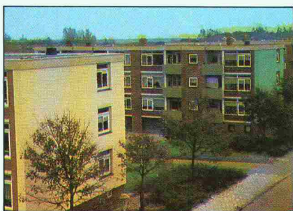
▲ Niederlande : Sanierung von Wohnhäusern, Den Helder.
