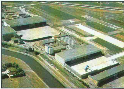
▲ Niederlande : Flughafen Schiphol, Amsterdam (Sanierung und Neubau).
