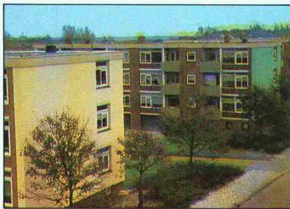
▲ Niederlande : Sanierung von Wohnhäusern, Den Helder.
