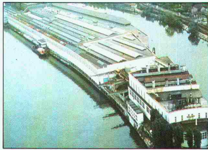
▲ Frankreich : Renault, Boulogne-Billancourt. (Sanierung)
