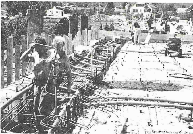
Bild 9. Die fertig verlegte Vorspannung auf der Gehwegseite
