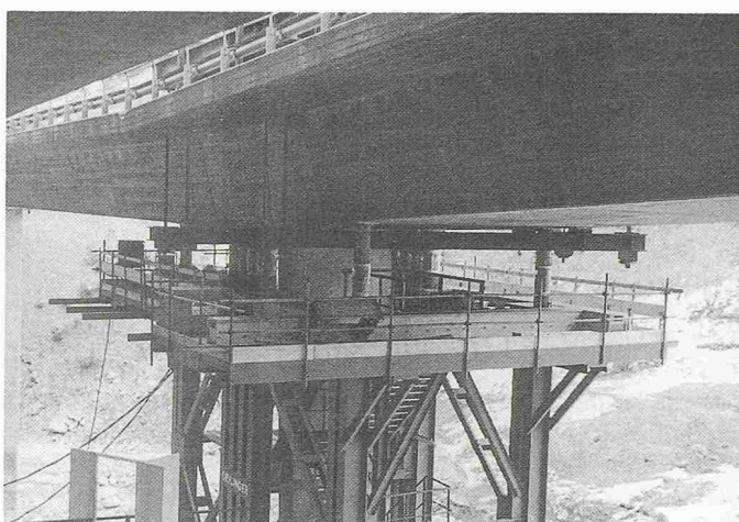
Bild 5. Hebung der Träger
