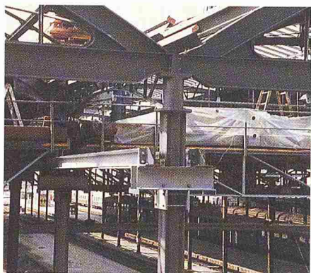
Bild 4. Nördliche Hallenverlängerung mit Schutz- und Arbeitsbühne
