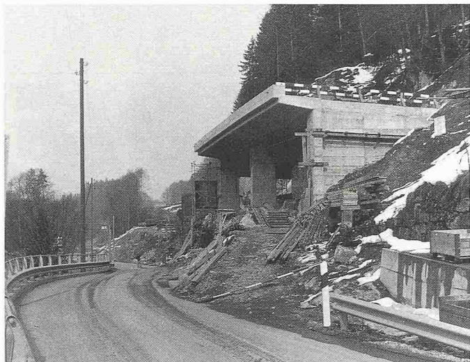
Bau einer Lehnenkonstruktion in Iseltwald-Sengg, 1985
