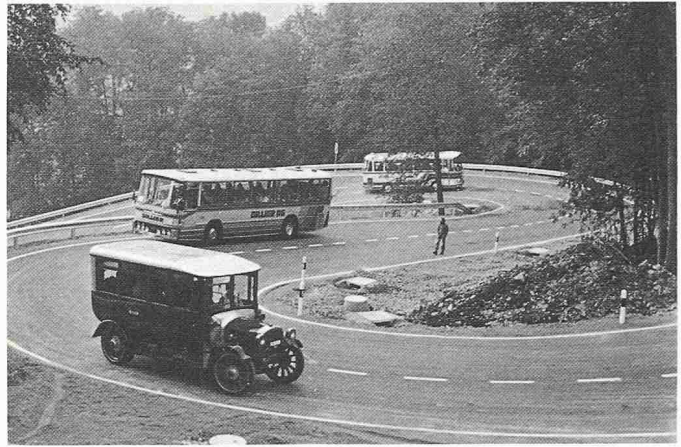
Bild 6. Fertiggestellte Notstrasse anlässlich der Verkehrsübergabe
