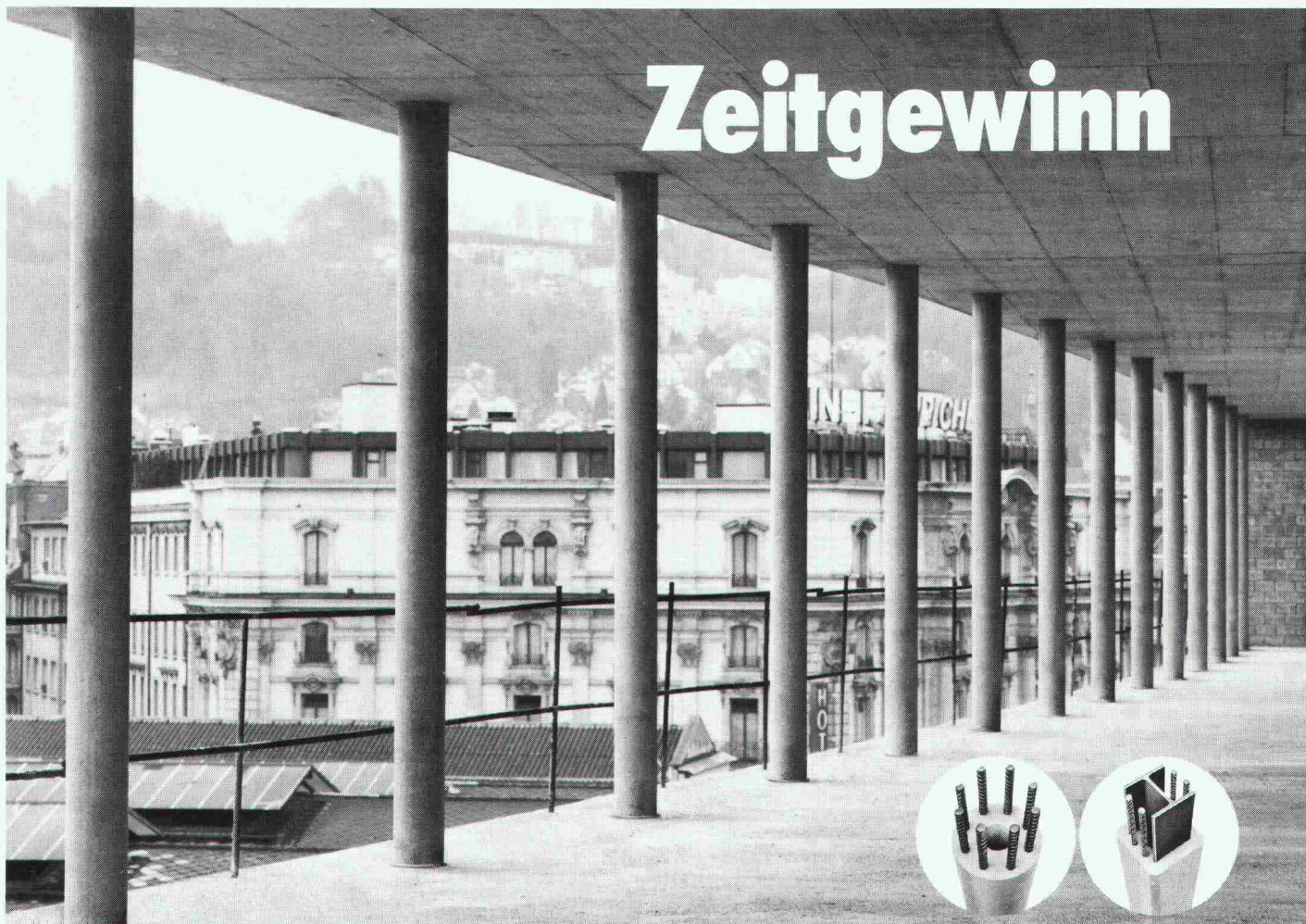
Neubau Bahnhof Luzern
