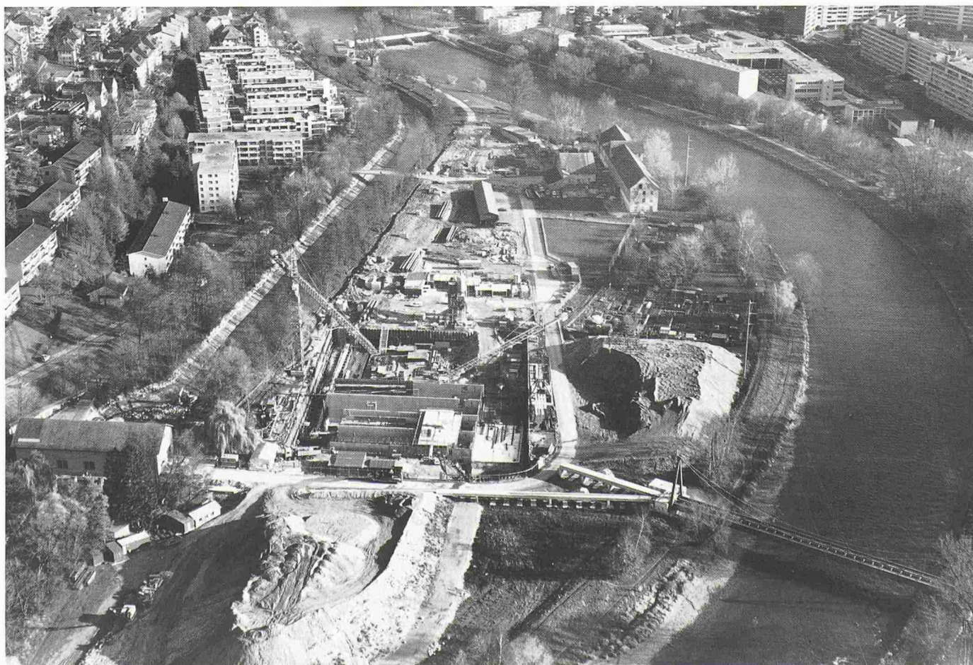
Werdinsel mit dem im Bau befindlichen Regenbecken.
