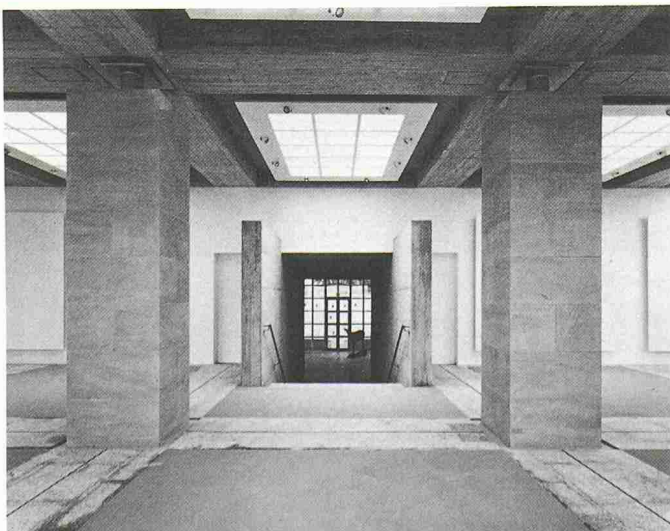
Übergang Altbau/Annexbau Süd
