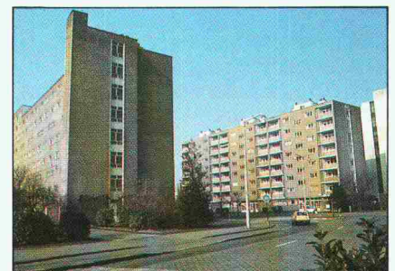
▲ Belgien : Sozialer Wohnungsbau, Gent. (Sanierung)
