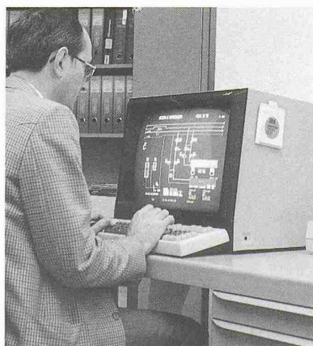
Bild 4. Renato Bernasconi, verantwortlich für Betrieb und Unterhalt sämtlicher haustechnischer Anlagen dieser UBS-Filiale, am Farbmonitor, an dem beliebige Anlageteile und deren Betriebsdaten dargestellt werden können
