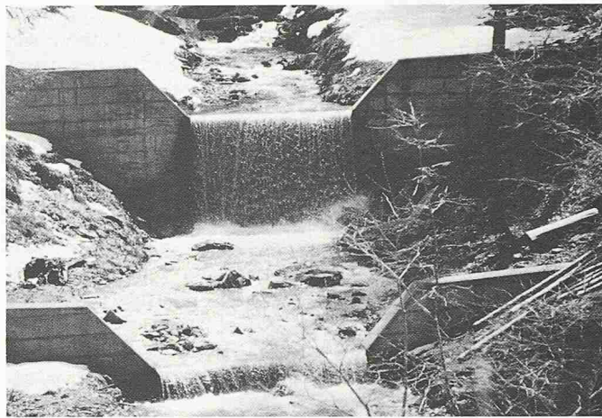
Bild 2. Bodenschutz im Berggebiet (Wildbachverbauung)
