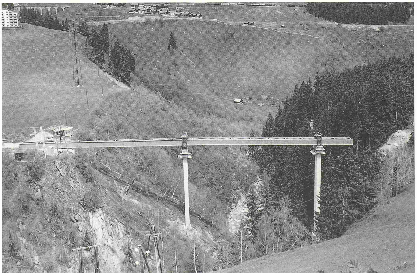
Bild 1. Ansicht der Baustelle
