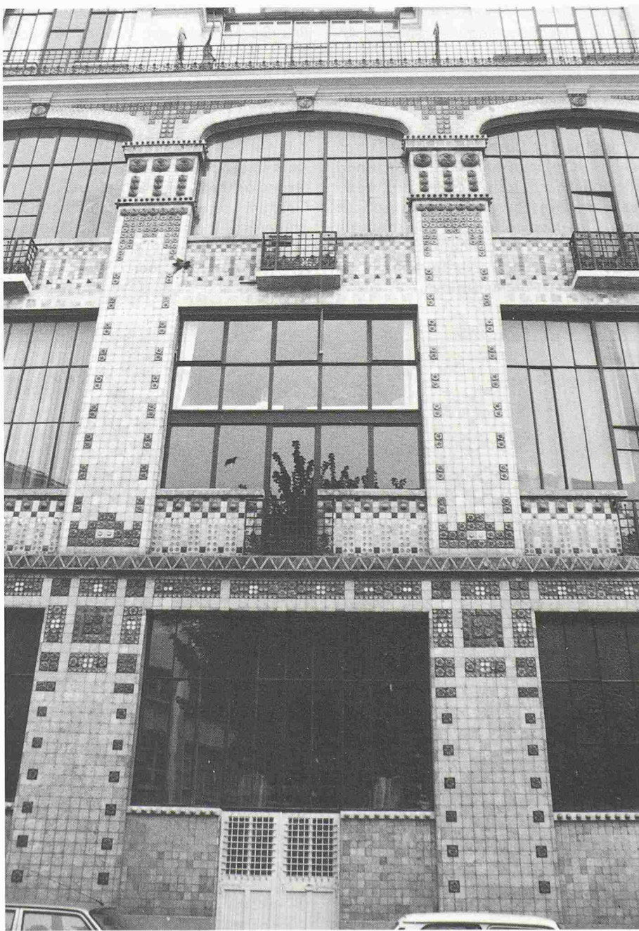
Bild 16. Jugendstil-Fassade eines Atelierhauses, 1901, Avenue Rapp, 7 e , Architekt: J. Lavirotte
