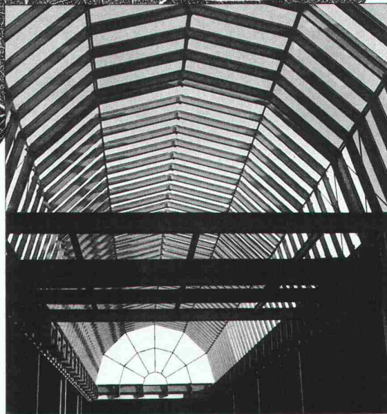
Stahl- und Industriebau
