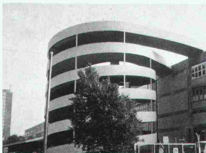
Rampe Parkhaus Migros Herdern
