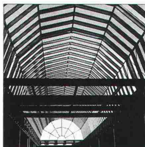
Hochbaukonstruktion (Unternehmensbereich Stahlbau)
