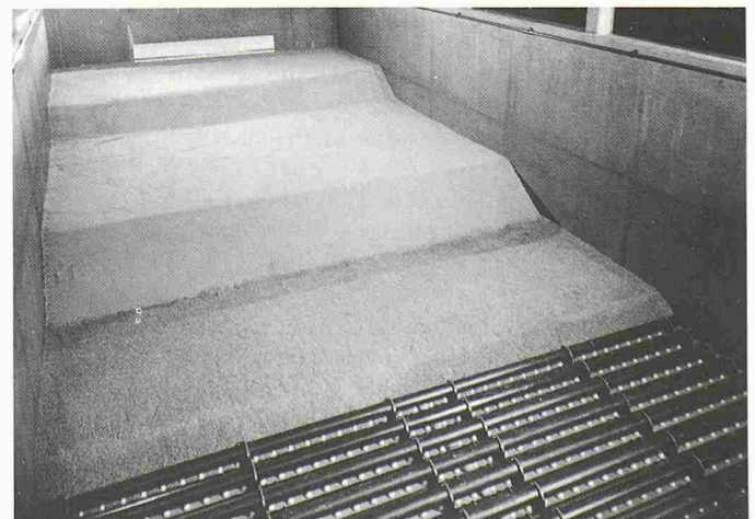
Bild 3. Blick in Drainagefilter 87
