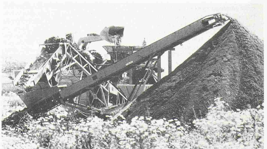
Betonwiederaufbereitungsanlage: Betonbrocken aus Abbrüchen werden mit einem Radlager in die Prallmühle eingegeben. Im Vordergrund das wiedergewonnene Baumaterial (Bild: BASF)
