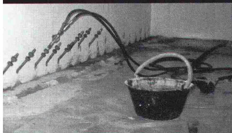
Elastische Abdichtungs-Injektion-Rascotex in einer Zivilschutzanlage.
