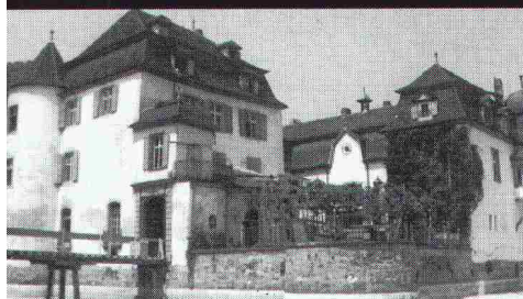
Rascolit-Flächenabdichtung und Horizontalsperre gegen aufsteigende Feuchtigkeit (Weiherschloss Bottmingen).
