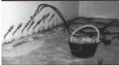
Elastische Abdichtungs-Injektion-Rascoflex in einer Zivilschutzanlage.
