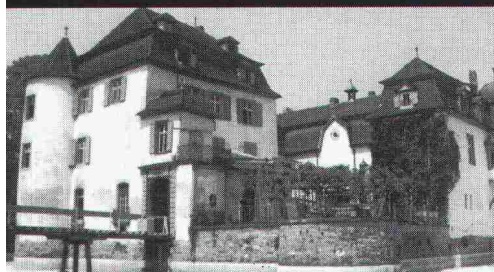
Rascolit-Flächenabdichtung und Horizontalsperre gegen aufsteigende Feuchtigkeit (Weier Schloss Bottmingen).
