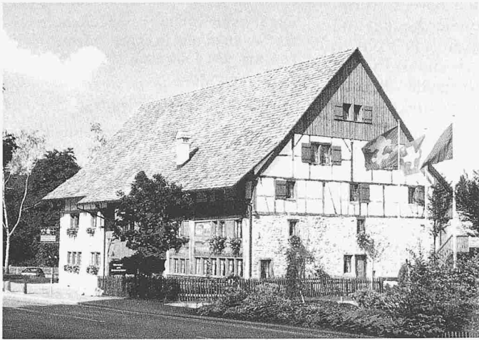
Gemeinschaftszentrum Stürmeierhuus, Freiestrasse 14, Schlieren ZH; Bauherrschaft: Evangelisch-reformierte Kirchgemeinde Schlieren; Architekt: LAD J. Pujol, Schlieren
