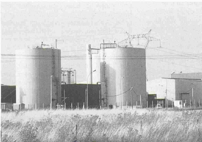
Die drei Faulbehälter der Abfallverwertungsanlage in Amiens (Bilder: Valorga)
