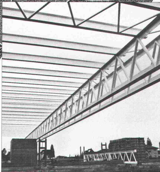
Stahlkonstruktion der Sporthalle Neuhof, Lenzburg
