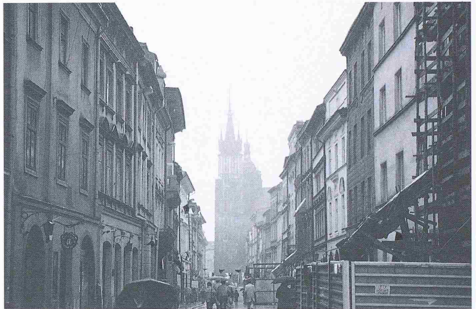
Bild 1. Florianska-Strasse in Krakau. In diesem auf einem Raster aufgebautem Quartier wurden bisher die grössten Anstrengungen für Renovationen unternommen
