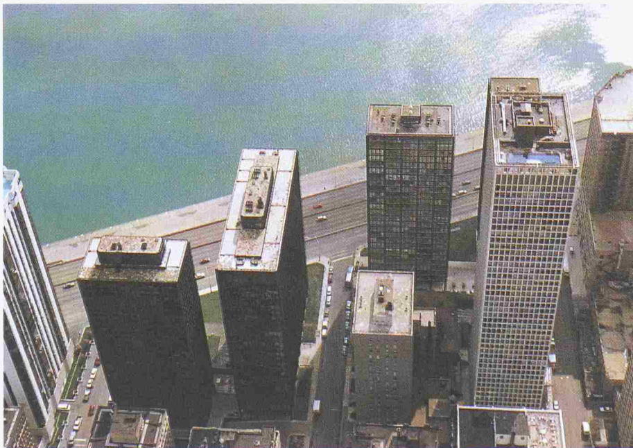
Chicago. Die Lake Shore Apartments von Mies van der Rohe sind in die Jahre gekommen ... Blick vom John Hancock Tower
