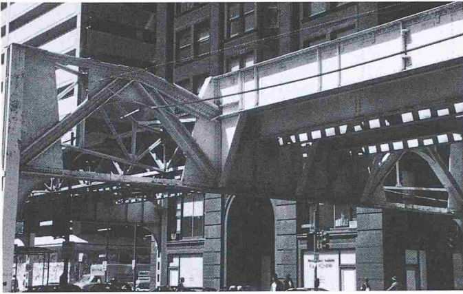
Die Unterkonstruktion der Hochbahn
