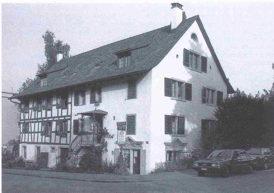
Hoffnungsstrasse 7. Die renovierte Fassade mit der freigelegten Riegelkonstruktion und den alten massiven Holzläden mit aufgemalten Mustern (Ballenläden). Zustand 1989. Foto: Büro für Denkmalpflege
