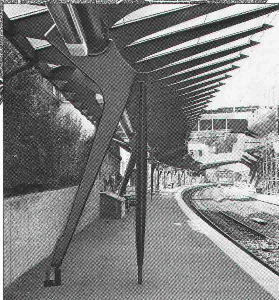
Stahl- und Industriebau
