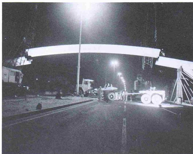
Bild 8. Versetzen des Bogenteiles in der Nacht
