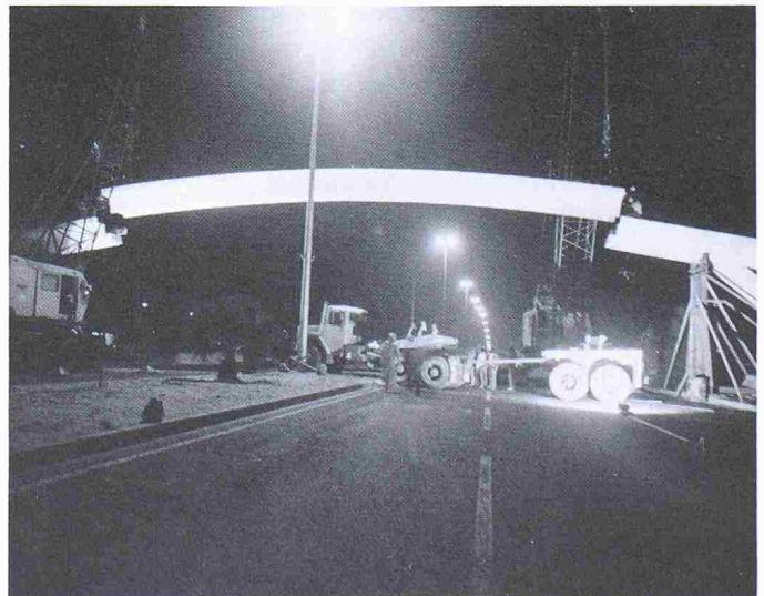
Bild 8. Versetzen des Bogenteiles in der Nacht
