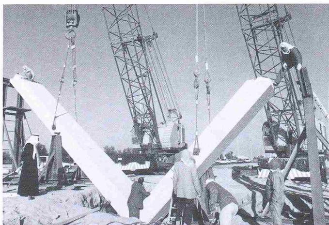
Bild 5. Einstellen der V-Stützen
