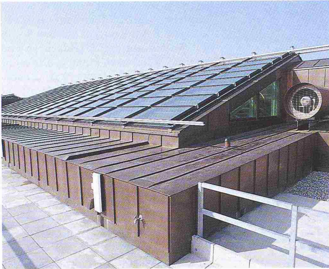
Hauptansicht des Atrium-Glasdaches mit einer überlappten Glas-Schürze nach dem Prinzip der Dachziegel
