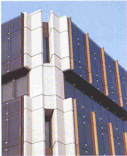
Auch im Eckbereich der Fassadenunterbrechung ist der Übergang zur Betonstruktur dem Versatz der horizontalen Linienführung angepasst
