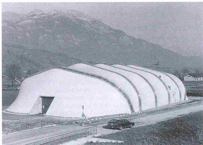
Grosse, helle Lagerhalle mit neuartiger Konstruktion
