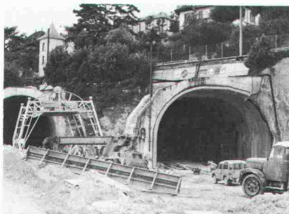
Tunnel Umfahrung Neuenburg, N5
