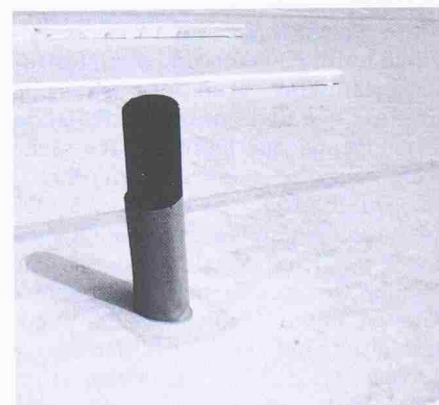
Sarnatex kann auch an Durchdringungen wie Dunstrohre wasserdicht angeschlossen werden
