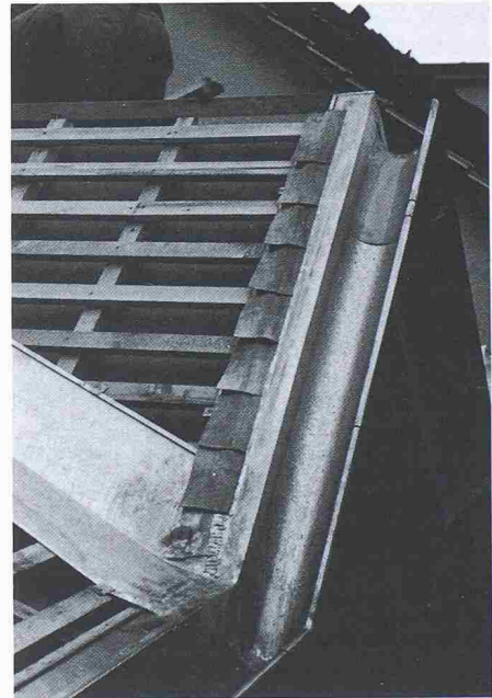
Bei einem solchen Dachstuhl ist es praktisch unmöglich, die erforderliche Luftdichtigkeit mit einer raumseitig der Tragkonstruktion liegenden Dampfbremse und Luftdichtungsschicht zu gewährleisten
