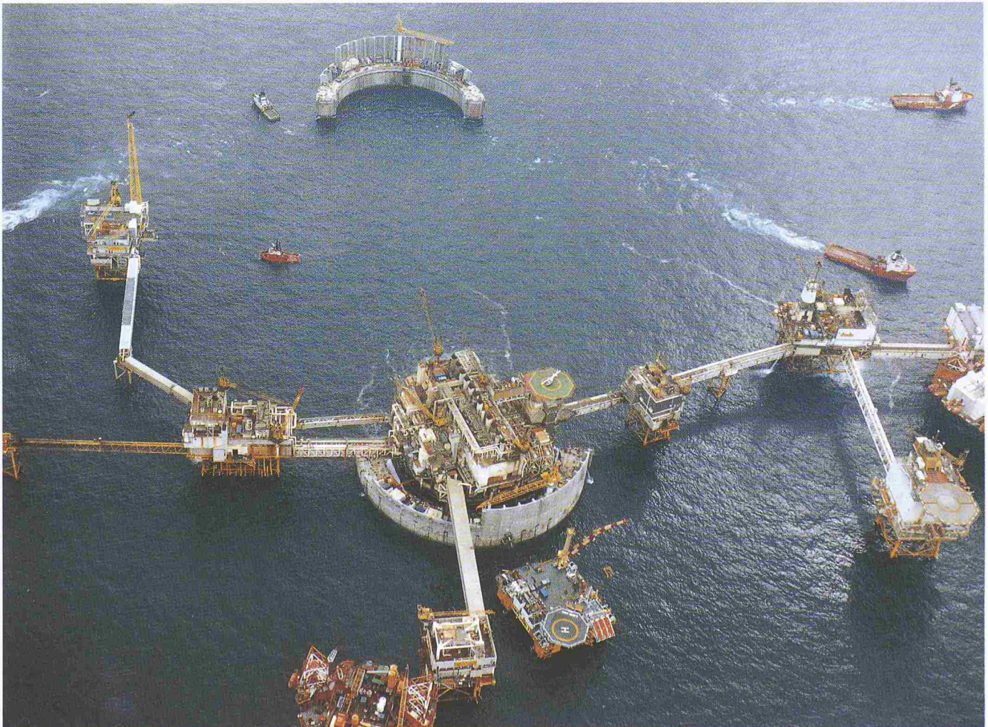
Bild 4. Transport einer Schutzwandhälfte von Bild 3 nach Norwegen zum Zusammenbau in einem Fjord (de Jong)
