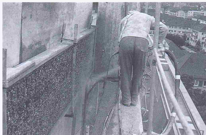
Bild 4. Applikation eines Besa-Spritzmörtels auf Microsilica-Basis (im Trockenspritzverfahren)
