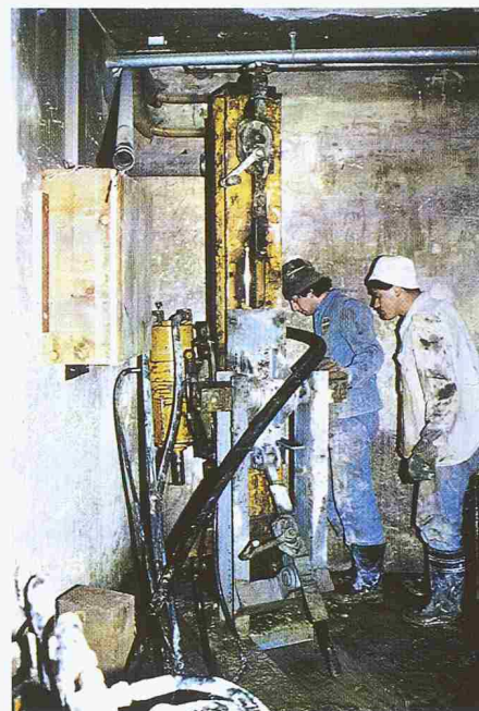
Bild 2. Unterquerung der Rämistrassenhäuser
