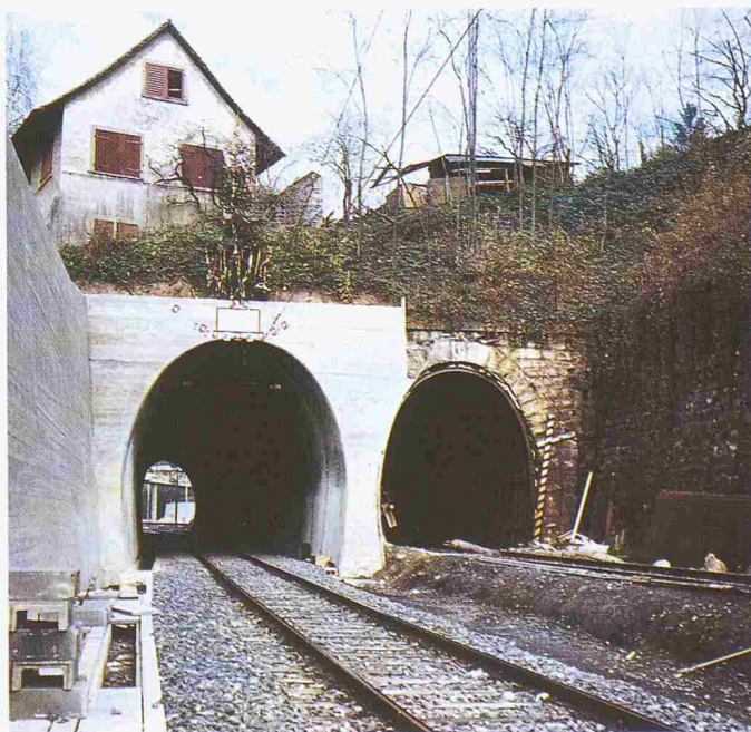
Bild 3. Rechtsufrige Zürichseelinie, Ausbau 1963-68, zweiter Hitzbergtunnel oberhalb Erlenbach
