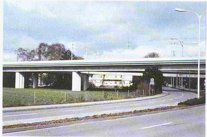
Bild 6. Neugutviadukt zwischen Stettbach und Dübendorf/Dietlikon
