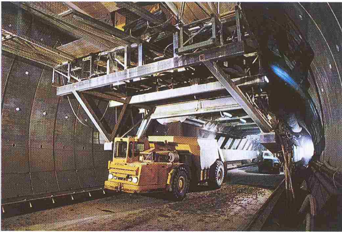
Bild 8. Verlad des Ausbruchs im Zürichbergtunnel
