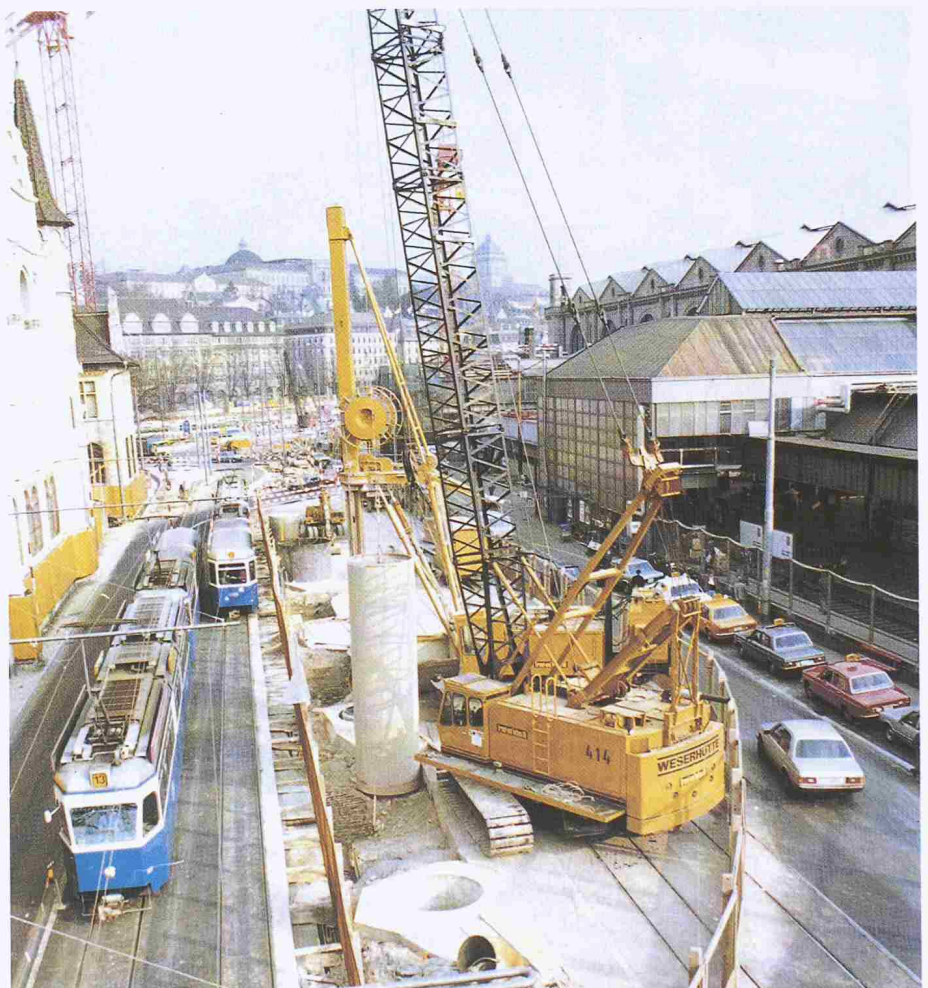
Bild 15. Bauarbeiten für die Pfahlfundationen in der Bauphase 2
