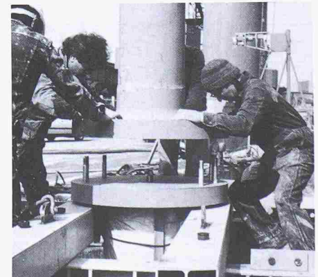
Bild 10. Verbinden der beiden Stützteile
