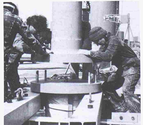
Bild 10. Verbinden der beiden Stützteile
