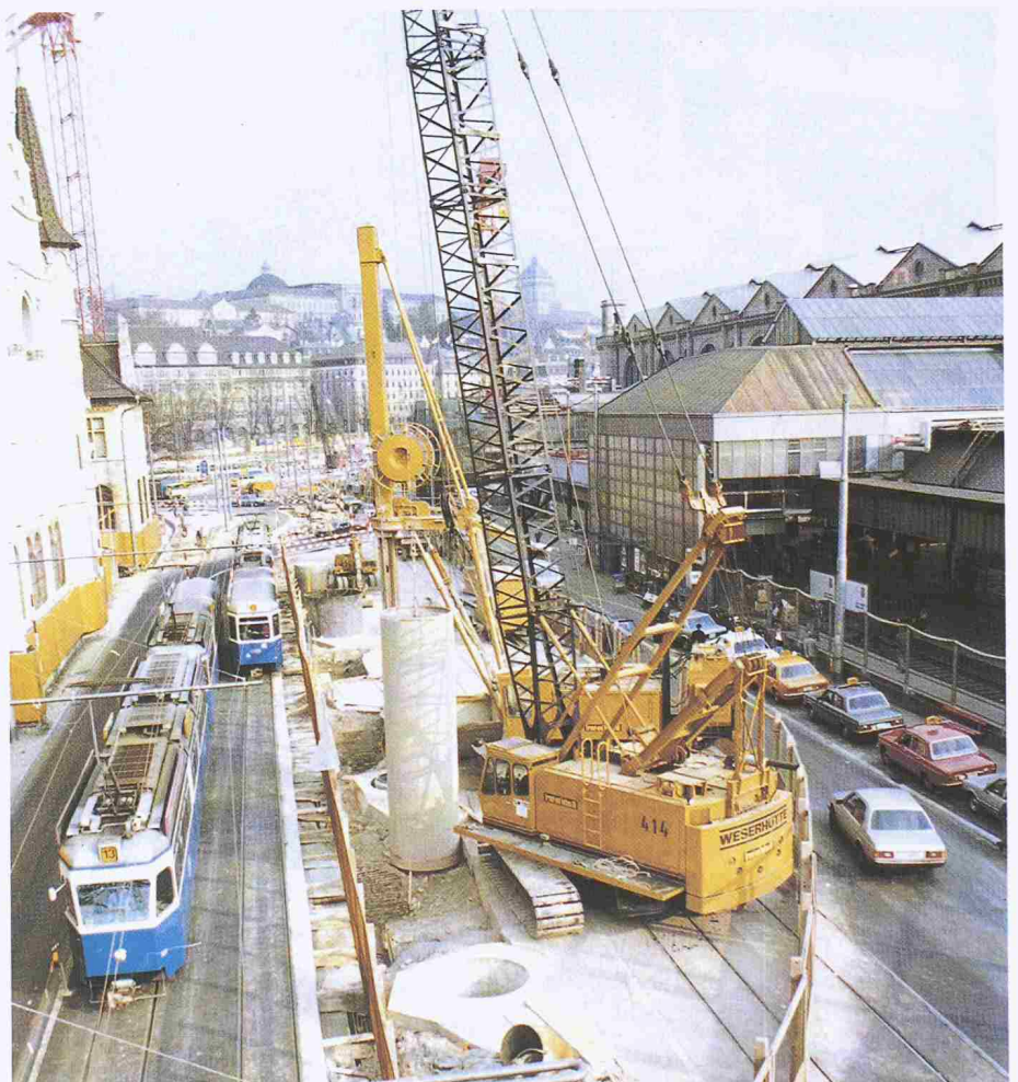
Bild 15. Bauarbeiten für die Pfahlfundationen in der Bauphase 2
