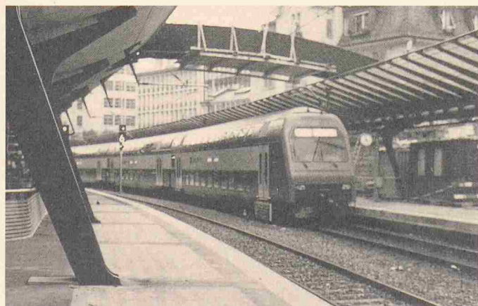
Zürcher S-Bahn (Bahnhof Stadelhofen): Sika-Konzepte im Einsatz
