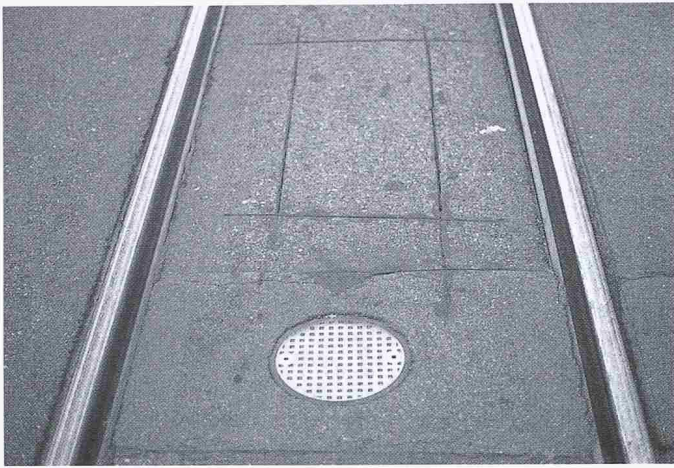
Bild 4. Mehr als 2500 Detektoren erfassen Strassenbahnen, Busse, Individualverkehr und Fussgänger. 16 Computer steuern die rund 400 Lichtsignalanlagen nicht nach starren Programmen, sondern voll dynamisch gemäss aktueller Verkehrslage und vorgegebenen Prioritäten
