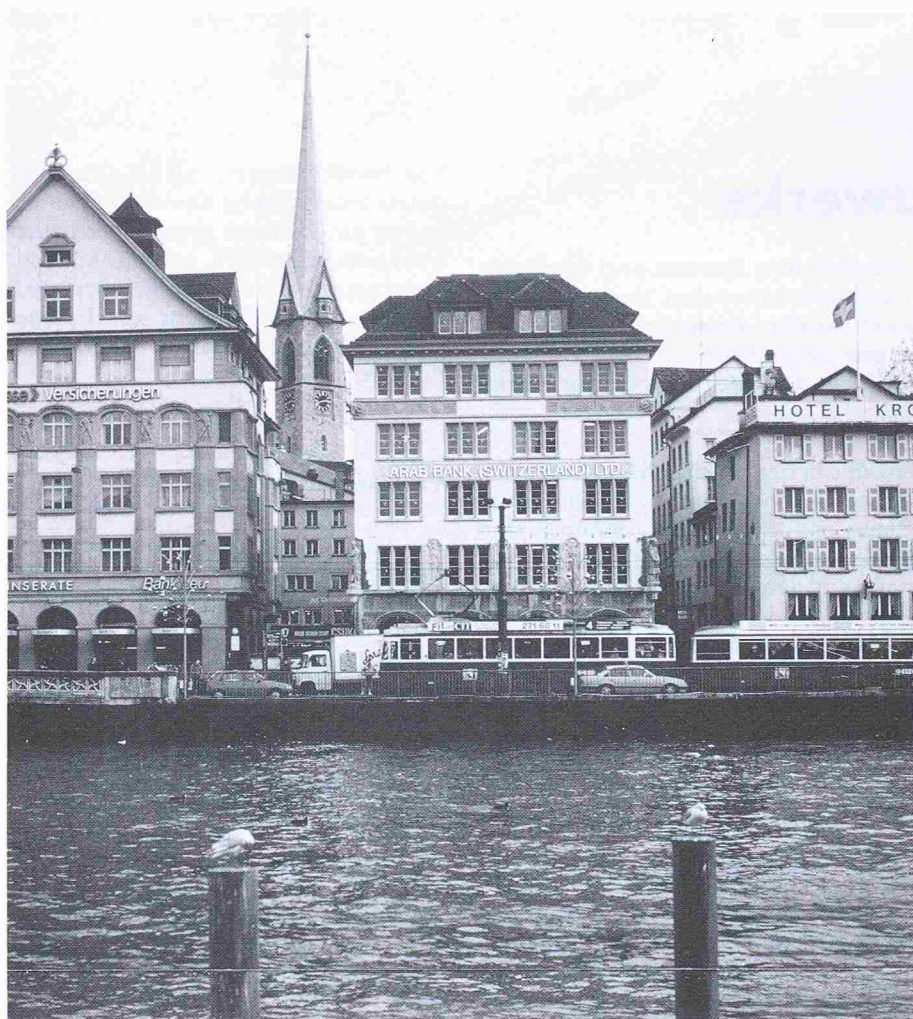
Bild 1. Blick von der Limmat auf die umgebaute und zusätzlich unterkellerte Liegenschaft am Limmatquai 92
