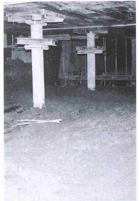
Bild 10. Aushub bei der Deckelbauweise
