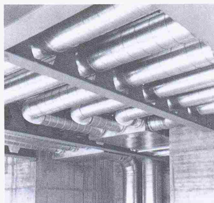
Bild 12. Problemlose Leitungsführung in Verbunddecken. Der Wegfall der Schalung führt zu kurzen Bauzeiten und wirtschaftlichen Bauabläufen.
